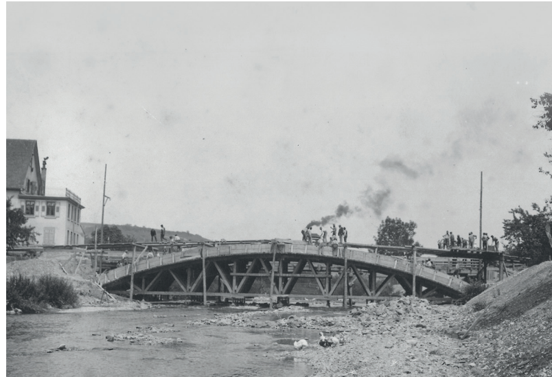
Beim Bau der Filsbrücke 1901
